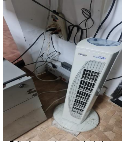
Falta de soportes en estanterías
