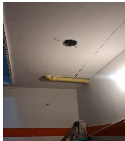
Cables expuestos
